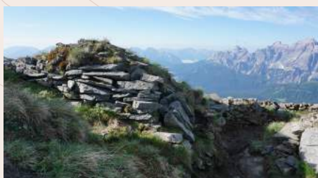
Lesesteinmauer vor Restauration durch Franz Brunner
